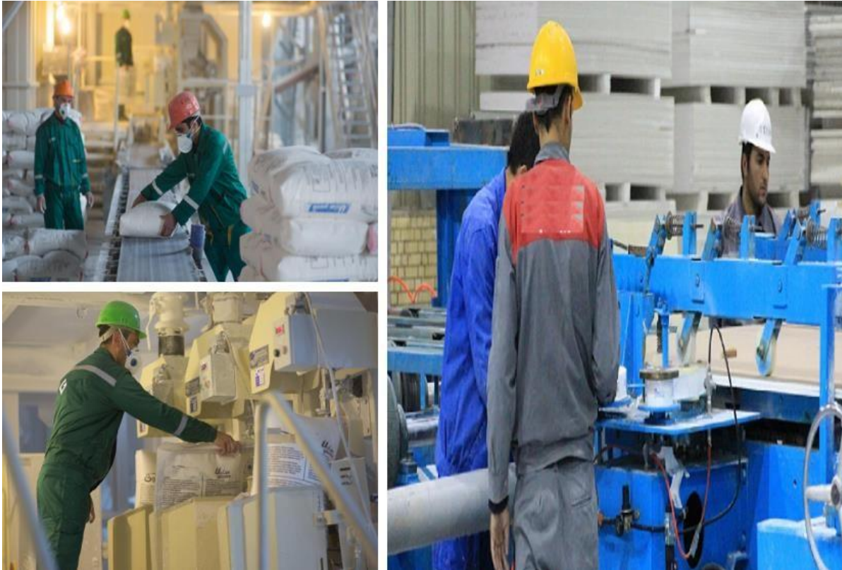
Şəkil 2.12. Gips məhsulları ilə işləyərkən təhlükəsizlik qaydalarına əməl edilməsi
