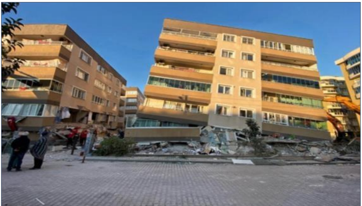
Şəkil 2. Yaşayış binasının çökməsi
