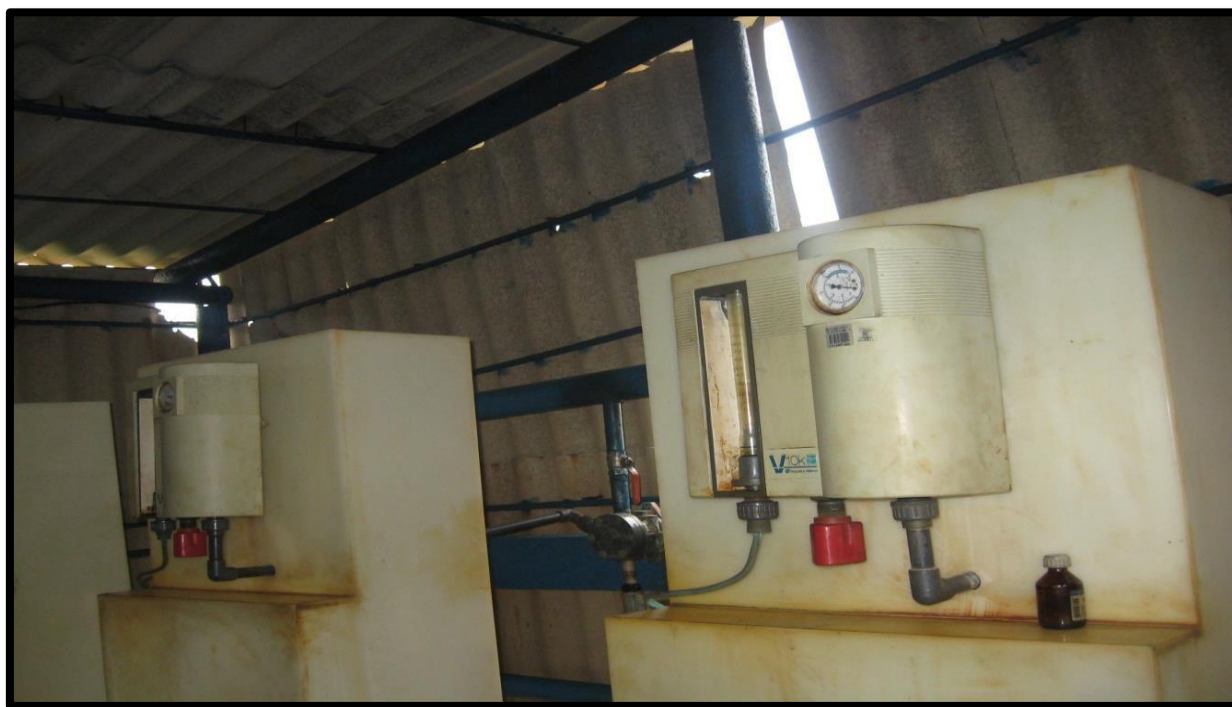
Şəkil 1. Kür-2 Sutəmizləyici qurğular kompleksində ilkin xlorlama sexi
