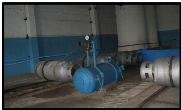
Şəkil 2. Kür-2 Sutəmizləyici qurğular kompleksində son xlorlama sexi
